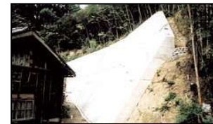
勝佐急傾斜地崩壊対策
