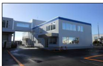
生駒化学工業 事務所棟
