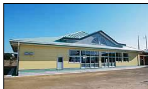
池新田幼稚園 遊戯室
