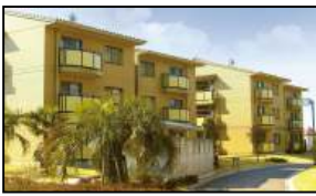
市営団地住宅
