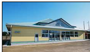
池新田幼稚園 遊戯室
