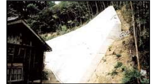
勝佐急傾斜地崩壊対策
