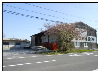
倉庫・資材置き場
