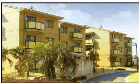
市営団地住宅
